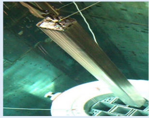
輸送容器からの吊り上げ
