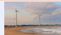
万葉の里風力発電所 (南相馬市)
