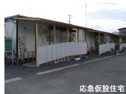
応急仮設住宅の建設状況
