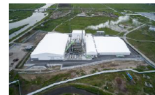
浪江町 仮設焼却施設
