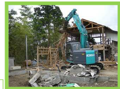
被災家屋等の解体
