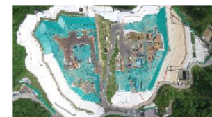
特定廃棄物埋立処分場
