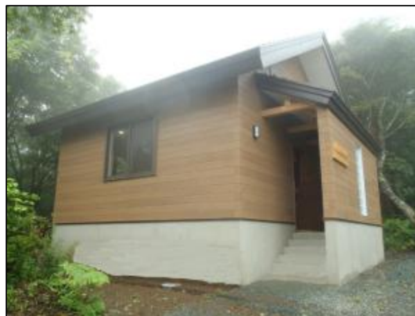
供用開始（階上岳山頂園地） （大開平休憩所 平成27年9月）
