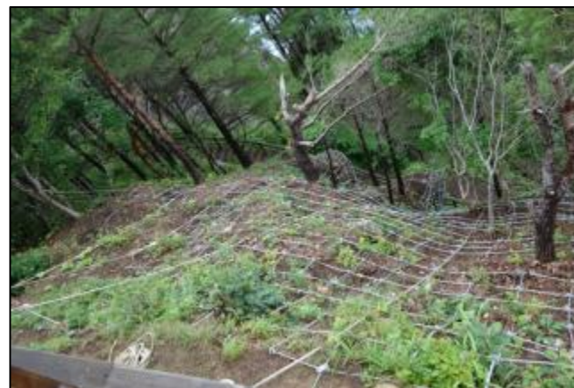
供用開始（北山崎線歩道） （平成25年8月）
