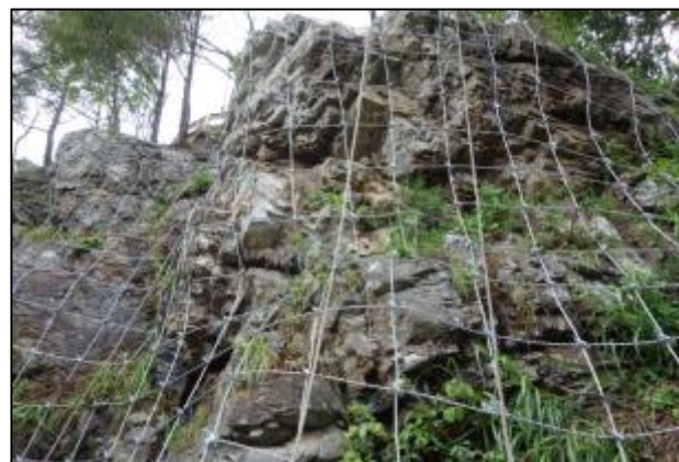
供用開始（北山崎園地） （平成25年8月）
