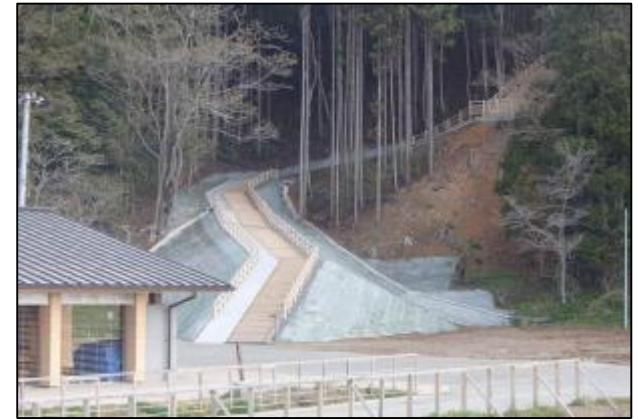
供用開始（津波避難路 平成25年5月）
