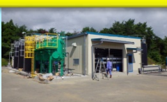
排水処理設備の管理
