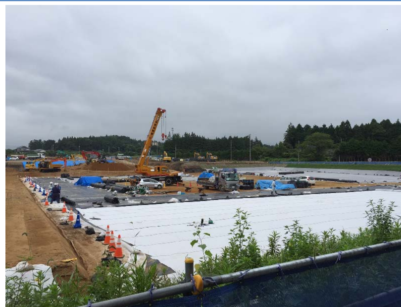
土壌貯蔵施設の建設状況（大熊工区）
