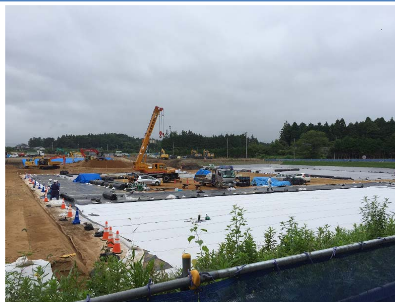
土壌貯蔵施設の建設状況（大熊工区）
