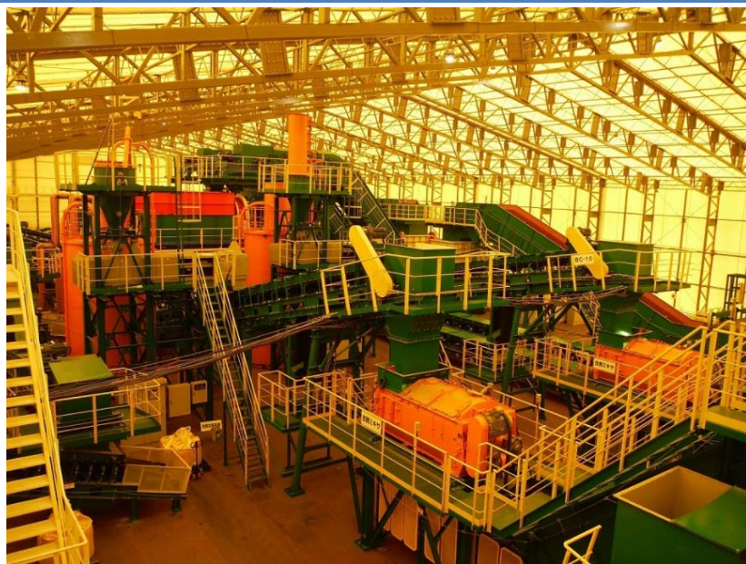
除染土壌等の受入・分別施設（双葉工区）
