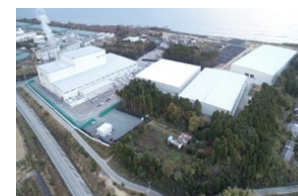
大熊町 仮設焼却施設
