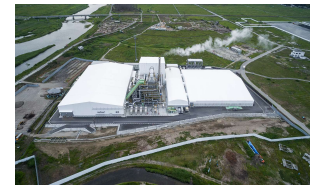
浪江町 仮設焼却施設
