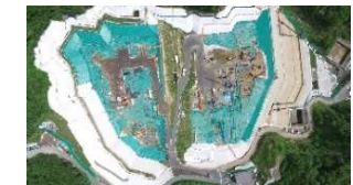
特定廃棄物埋立処分場
