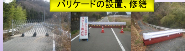
バリケードの設置、修繕
