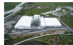
浪江町 仮設焼却施設
