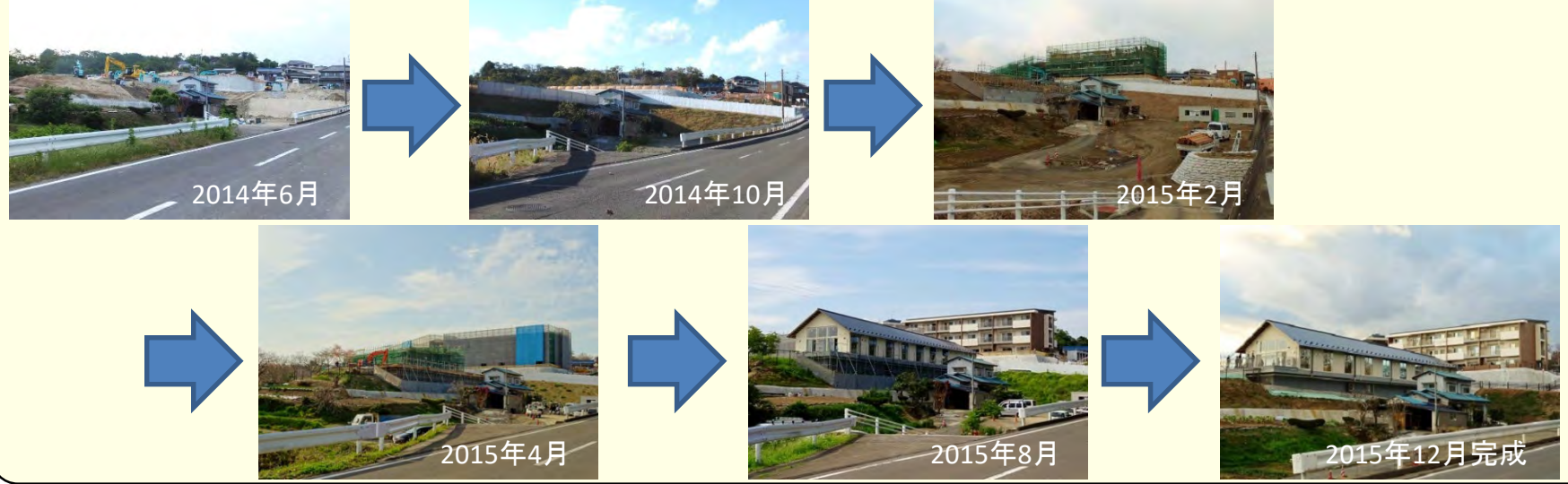
例) 宮城県七ヶ浜町花淵浜地区 災害公営住宅
