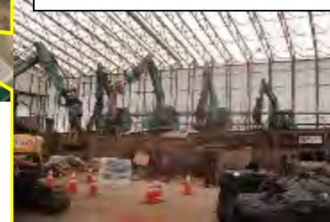
受入・分別施設 施設内(大熊町)
