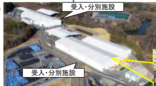
受入・分別施設 外観(大熊町)
