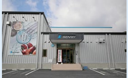
水産加工場外観 （女川町）
