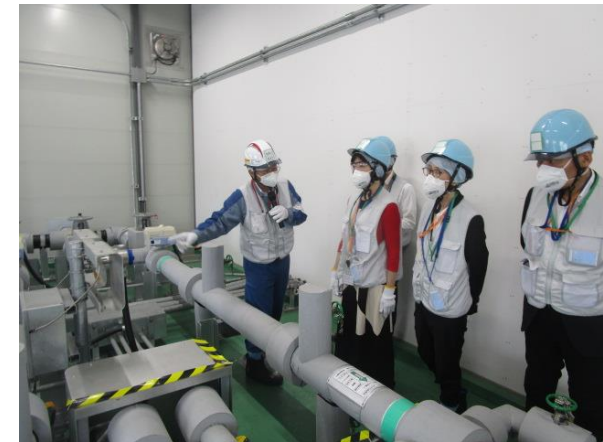
ALPS処理水の緊急遮断弁の視察
