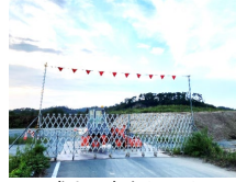
盛土工事中 (R5.9)
