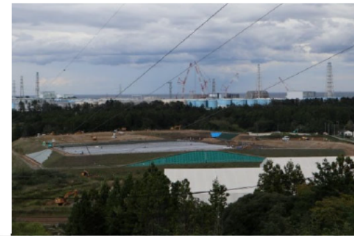
中間貯蔵施設と福島第一原子力発電所 (R5.10)
