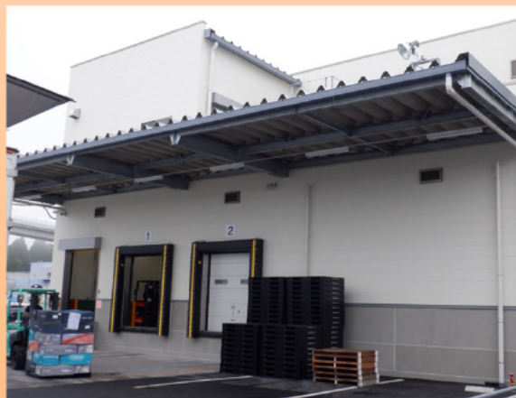
◀グループ補助金を活用して整備された水産加工施設 (気仙沼市)
