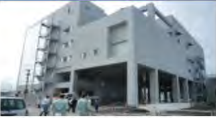
製氷・貯氷施設(宮城県気仙沼市) 平成24年3月交付決定。 平成24年10月中旬から稼働開始。
