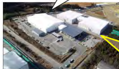
受入・分別施設 外観(大熊町)
