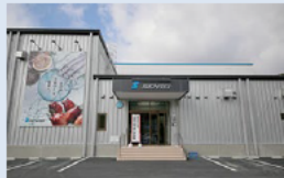
水産加工場外観 （女川町）
