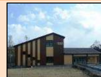
野蒜駅(新駅舎)
