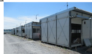
応急仮設住宅団地の退去完了 (令和3年3月、陸前高田市)
