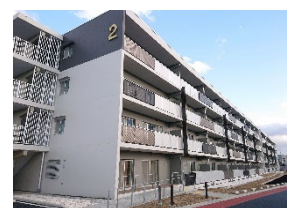
災害公営住宅の整備完了 (令和2年12月、盛岡市)
