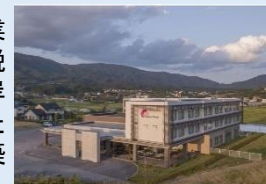
宿泊施設外観 (陸前高田市)
