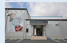
水産加工場外観 (女川町)
