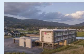
宿泊施設外観 (陸前高田市)
