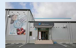
水産加工場外観 (女川町)
