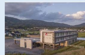
宿泊施設外観 (陸前高田市)
