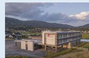
宿泊施設外観 (陸前高田市)
