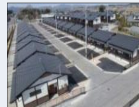
災害公営住宅(相馬市)
