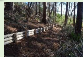
筋工の設置により土壌移動を抑制
