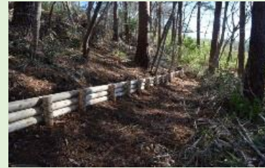
丸太筋工の設置による 土壌流出対策
