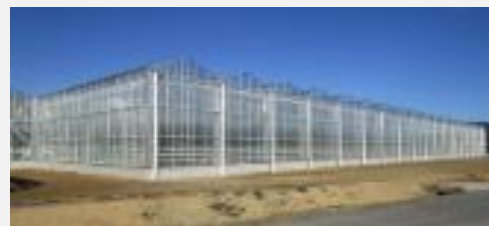
軒高の高いガラス温室
