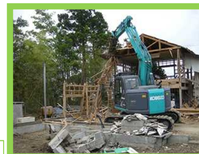
被災家屋等の解体
