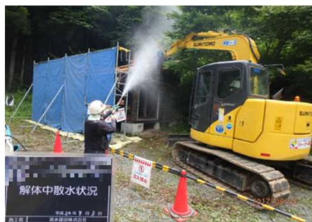
被災家屋等の解体の様子
