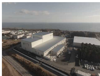
大熊町の仮設焼却施設
