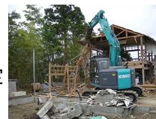
被災家屋等の解体
