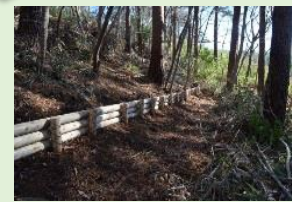
筋工の設置により 土壌移動を抑制
