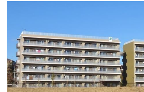
災害公営住宅 (宮城県石巻市)
