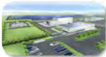
再エネ由来大規模水素製造実証拠点（浪江町）
