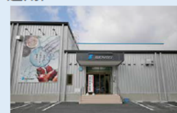
水産加工場外観 (女川町)
