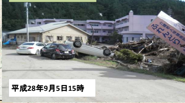
⑤ 乙茂地区の被害
