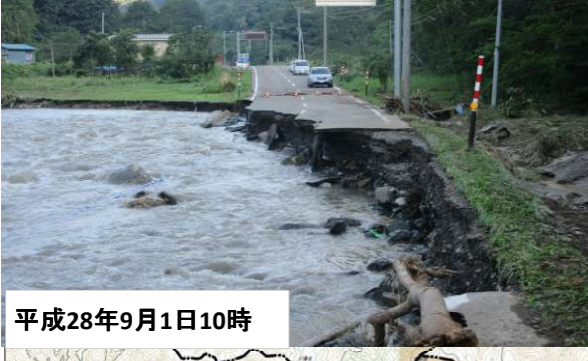
② 県道久慈岩泉線の被害(安家地区)
