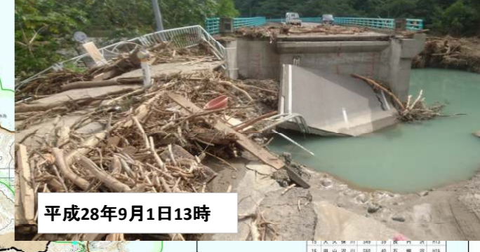
⑦ 乙茂橋の被害
