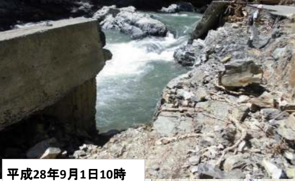
① 県道普代小屋瀬線の被害(安家地区)
