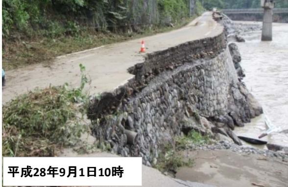
③ 国道455号の被害(二升石地区)
