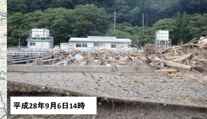
⑧ 小本鮭鱒人工孵化場の被害
