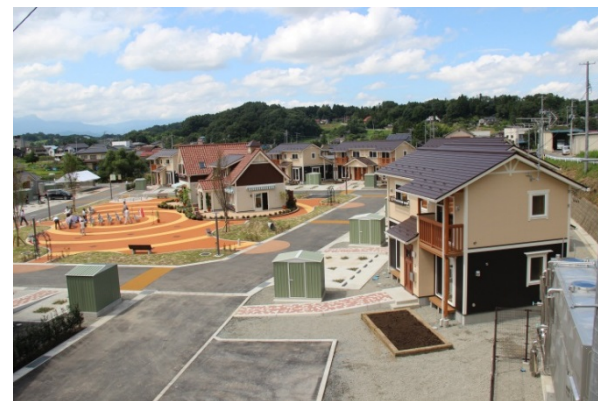
飯舘村営復興公営住宅・飯野町団地（福島市）
