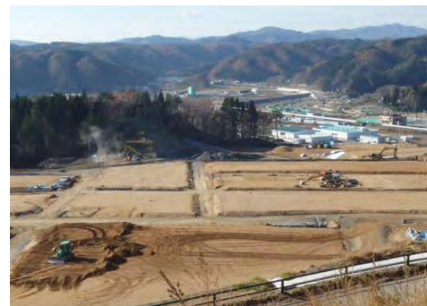
宮古市 防災集団移転住宅団地整備 (平成26年11月撮影)
