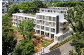
(住棟改修・活用)
