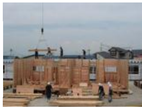
(出典)国土交通省HP 「東日本大震災における応急仮設住宅の建設事例」
