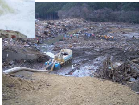
▲排水作業の様子 (宮城県石巻市)
