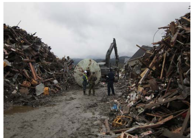
津波により災害を受けた国道の啓開完了
