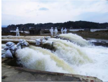
▲排水作業の様子 (福島県相馬市)
