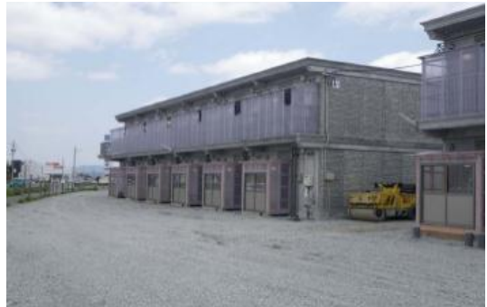
(出典)国土交通省HP 「東日本大震災における応急仮設住宅の建設事例」
