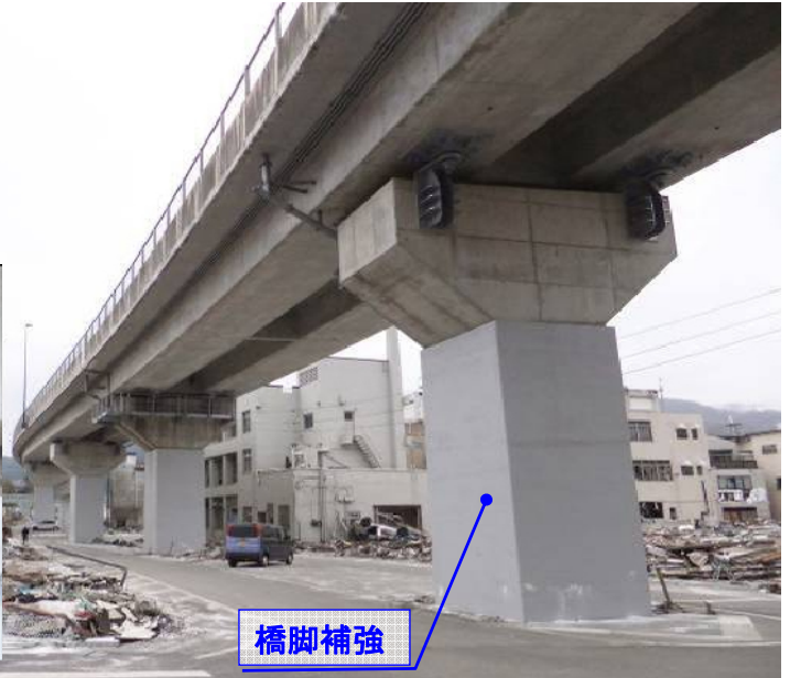
国道45号釜石高架橋
