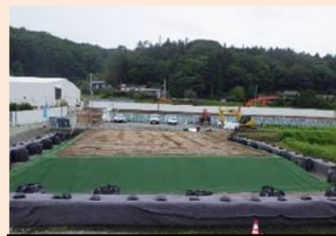
飯舘村実証事業における 除去土壌を用いた盛土実証ヤード
