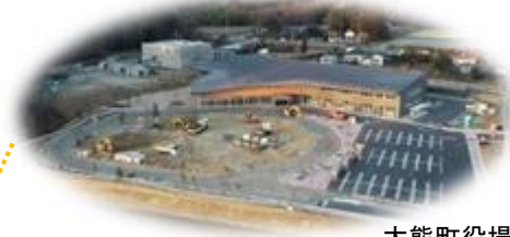
大熊町役場新庁舎(建設中)
