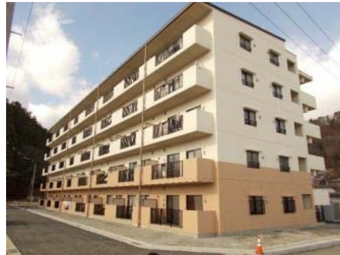
災害公営住宅（岩手県宮古市）
