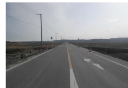
撤去後(平成28年3月)
