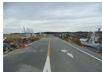
撤去前(平成26年7月)
