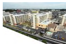
災害公営住宅
