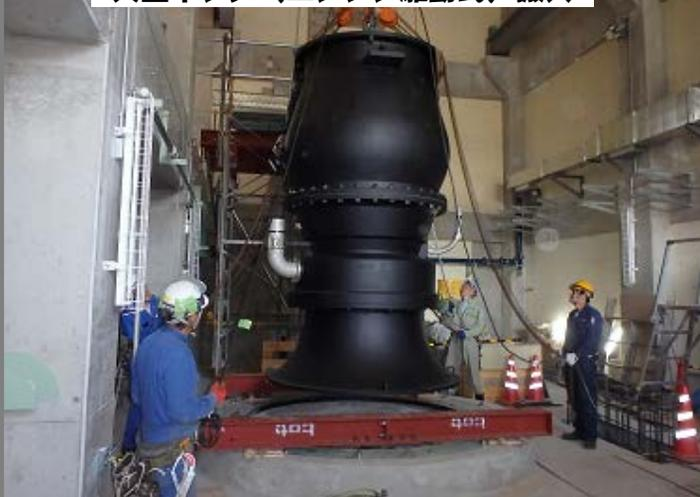
ポンプ場は鉄筋コンクリート造3階建て、延べ床面積は約1,230㎡。電動式(常時)とエンジン駆動式(大雨時)のポンプが、各2基(計4基)計画されております。排水能力は毎秒9.8m<sup>3</sup>(1分間で25mプール1杯分)で、雨水を神山川に強制排水する計画になっています。
