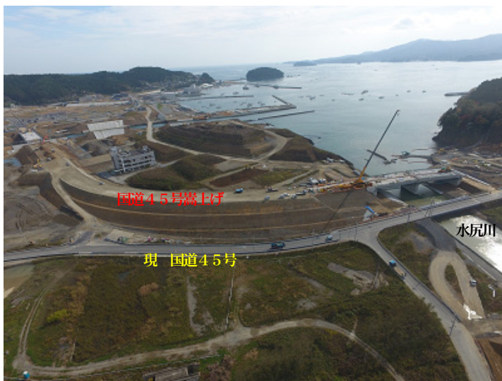
仮設橋梁により2車線復旧（水尻橋）
