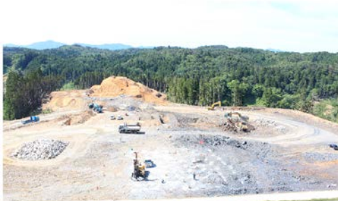
法面上から見た南三陸町防集清水団地
