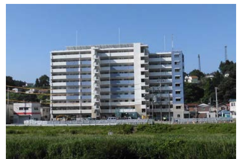
9月入居に向け急ピッチで建築が進む 気仙沼市四反田地区災害公営住宅
