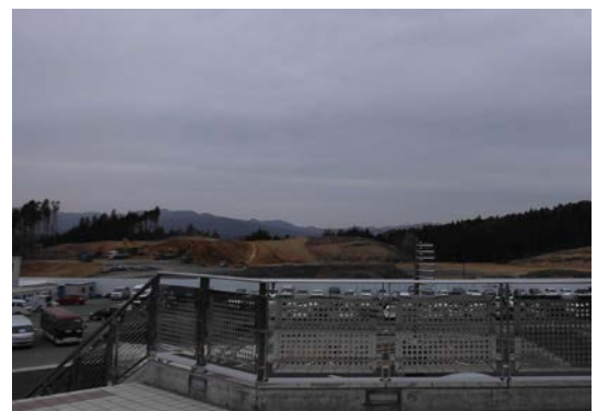
着々と造成工事が進む南三陸町の志津川東地区西工区
