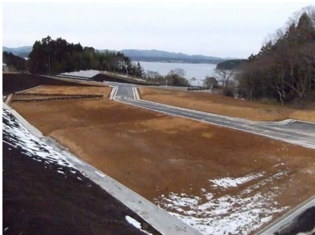
昨年12月に竣工した戸倉地区の津の宮原団地。 法面を上り志津川湾を望む。
