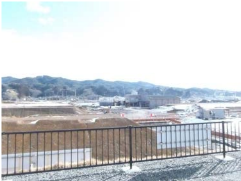
気仙沼地域の都市再生区画整理事業（鹿折地区）の盛土の様子
