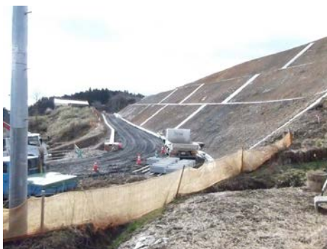
歌津地区の道路事業（高台接続道路）工事の様子
