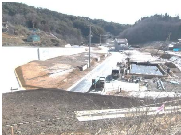
昨年10月に竣工した気仙沼地域の小々汐地区防集。 2月現在、着々と住宅建築が進む。
