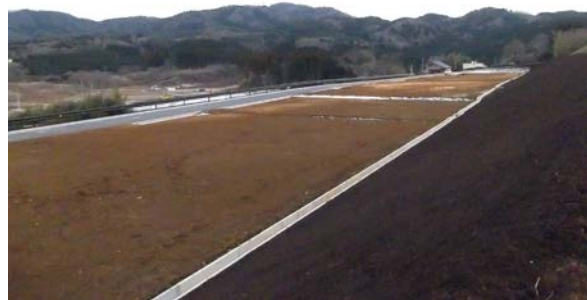
昨年12月に竣工した戸倉地区の松崎団地。 その低地部では、国道398号の付け替え工事中。
