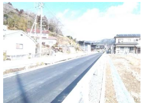
整備が進む大船渡線BRT気仙沼～鹿折唐桑駅間の専用道
