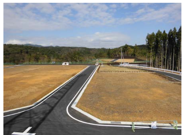
南三陸町 西田・細浦地区防集（26年9月竣工）
