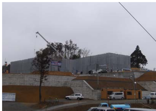
南三陸町の災害公営住宅整備事業の工事の様子 (歌津地区 災害公営名足住宅)
