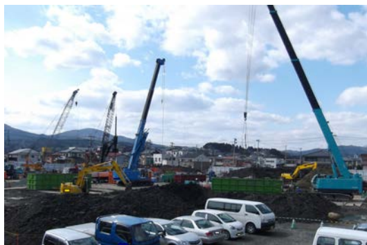
気仙沼市の災害公営住宅整備事業の工事の様子 (南郷地区)
