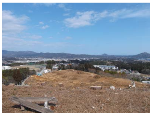
気仙沼市の災害公営住宅整備事業の工事の様子 (牧沢地区)
