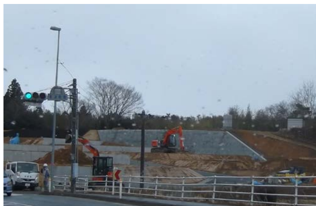
南三陸町の防災集団移転促進事業の工事の様子 (歌津 港地区 塚団地)
